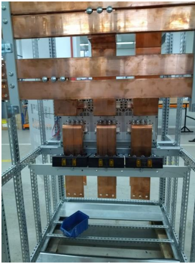
Eksi bakır barası ve ek bakırı Artı bakır barası ve ek bakırı
