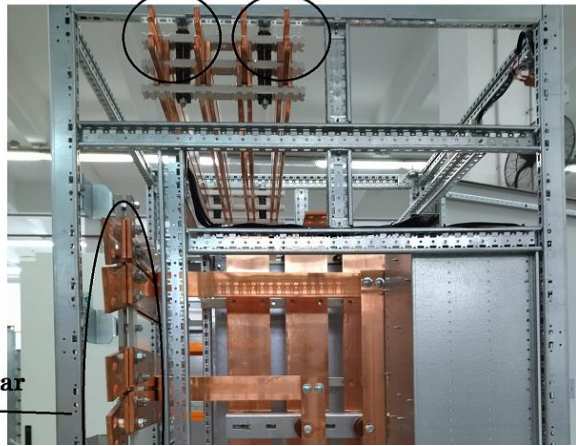
Eksi bakır barası ve ek bakırı Artı bakır barası ve ek bakırı
